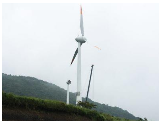
熊本地震で損壊し撤去された久木野風力発電(熊本県)
